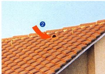
② **Lüftungziegel:** Einflugmöglichkeit in das Dach, jedoch nur auf einer Seite des Hauses, um Durchzug zu vermeiden (Sieb heraustrennen). Es gibt auch spezielle Fledermausziegel im Handel (s. Adresse AG Ziegeldach). Unterspannbahn an diesen Stellen etwas öffnen für den Durchschlupf in den Dachraum, ggf. Überlappungen zum Durchkriechen ausbilden (für Fledermaus). Im Firstbereich und in nicht ausgebauten Dachbereichen keine Unterspannbahnen verwenden.
